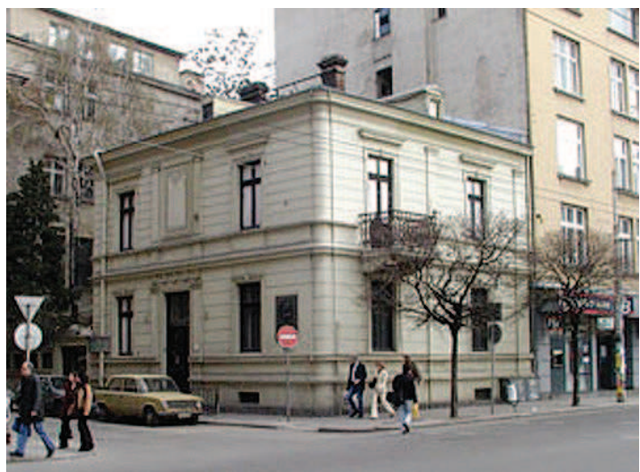
Домът музей на Вазов, намиращ се на ъгъла на улиците "Г.С. Раковски" и "Ив. Вазов" в София. Къщата е построена през 1895 г., тук писателят е живял и творил най-дълго време
